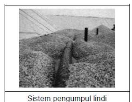
Gambar 16 - Desain Pemasangan Pipa Drainase Lindi dan Gas Vertikal
