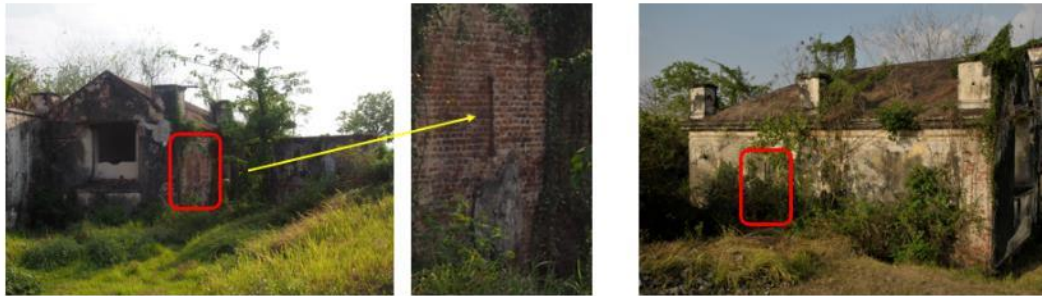
Gambar F.16 Lubang bidik yang terdapat pada dinding luar bangunan 8,9,10 dan 11
