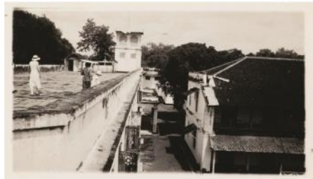
Atap pada bangunan I
