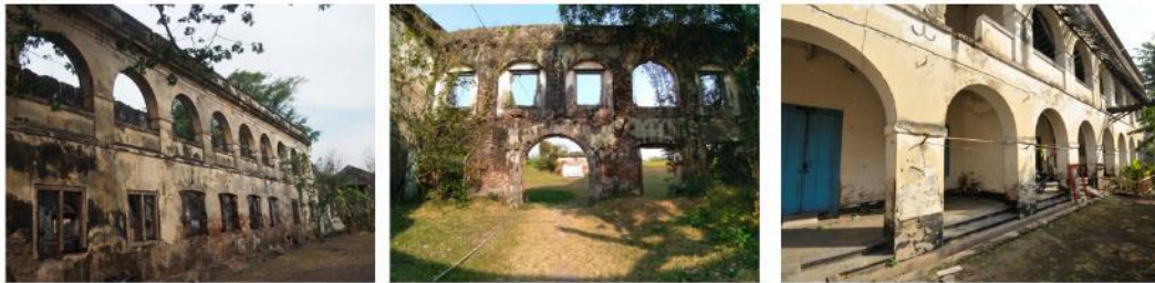
Kondisi bangunan-bangunan dalam benteng yang sudah tidak ditempati (kiri) dan yang masih ditempati (kanan)
