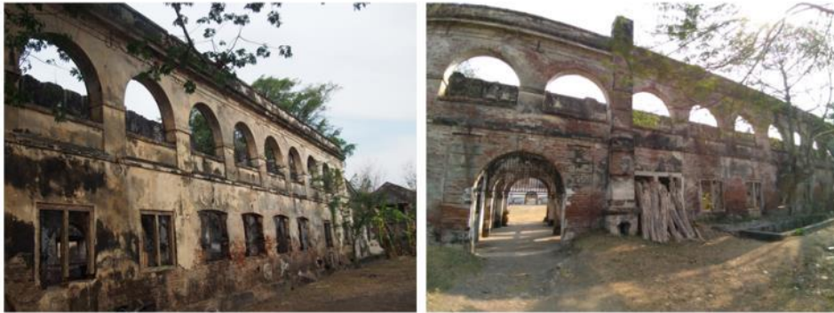
Gambar F.14 Dinding bangunan yang merupakan dinding struktur
