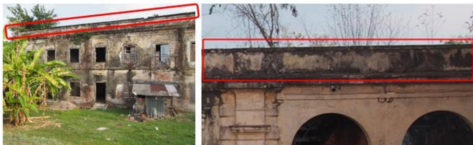
Gambar F.27 parapet pada pinggi atap bangunan 1,2, 3 dan 4
