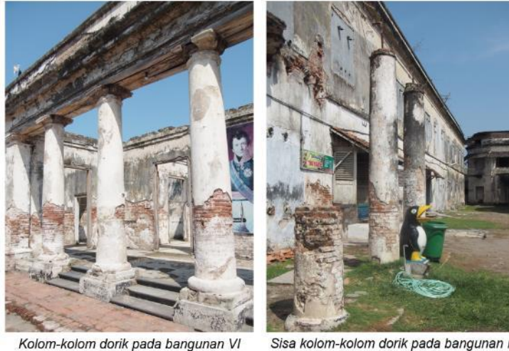
Gambar F.21 Sisa Kolom pada bangunan
