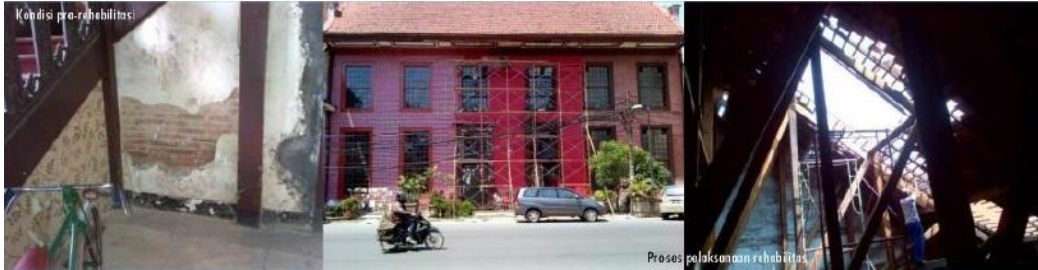
Gambar C.1.6 rehabilitasi Toko Merah, Jakarta Barat
