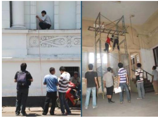
Gambar B.1.15. Kegiatan pengukuran bangunan Sumber: Konservasi Gedung De Javasche Bank; Surabaya, 2009
