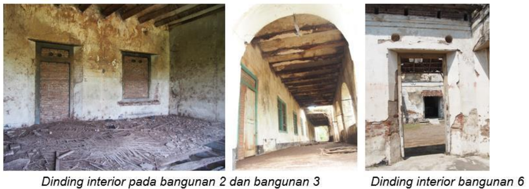
Gambar F.36 Dinding Interior bangunan 2,3 dan 6
