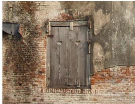
Jendela kayu berdaun ganda dengan daun jendela papan kayu
