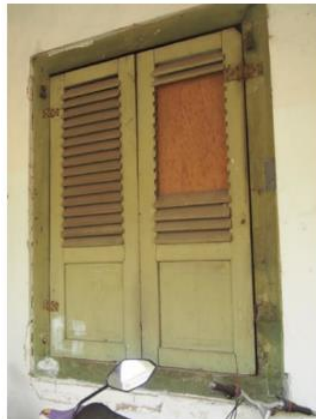
Jendela kayu berdaun ganda, dengan daun jendela panel kayu dan kreyyak
