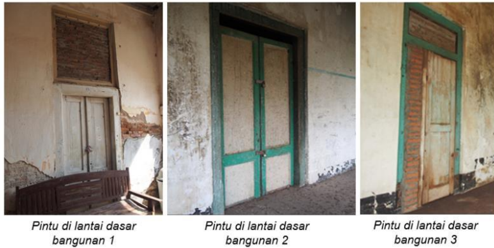
Gambar F.33 Pintu pada ruang dalam
