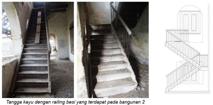
Gambar F.43 tangga bangunan benteng
