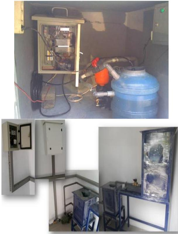
Gambar 1.14 sistem pompa untuk pengambilan sampling air
