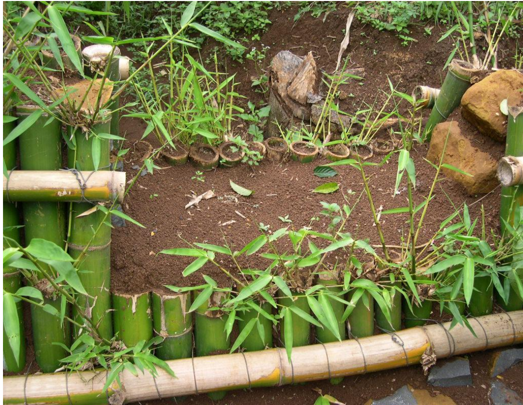
Gambar 4.46. Bio Gully Plug telah terisi tanah dan tanaman bambu mulai tumbuh
