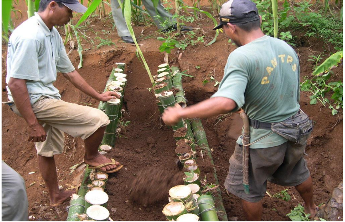
Gambar 4.43. Proses pembuatan Bio Gully Plug
