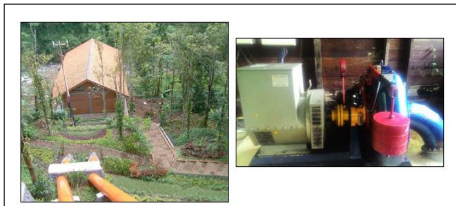
Gambar 75. Contoh bangunan dan instalasi microhydro
