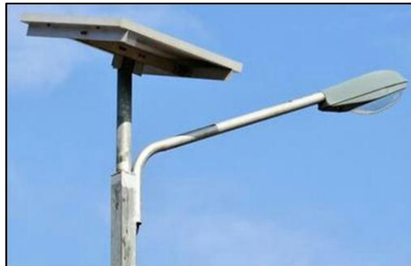
Gambar 74. Contoh penerangan jalan dengan panel surya
