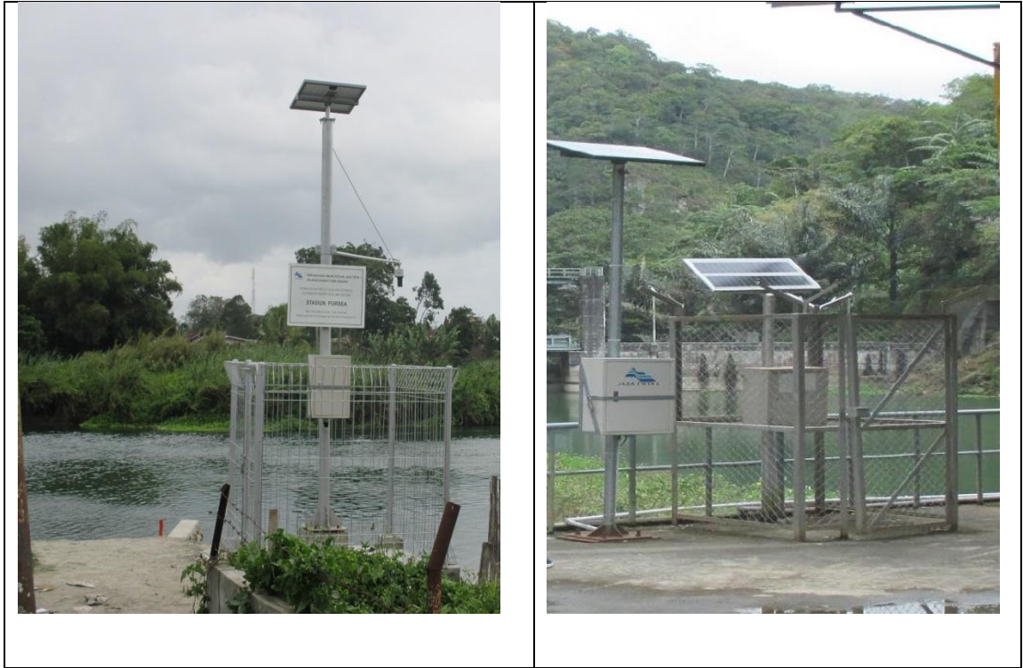
Gambar 8. Contoh Bangunan Pelindung Tidak Permanen
