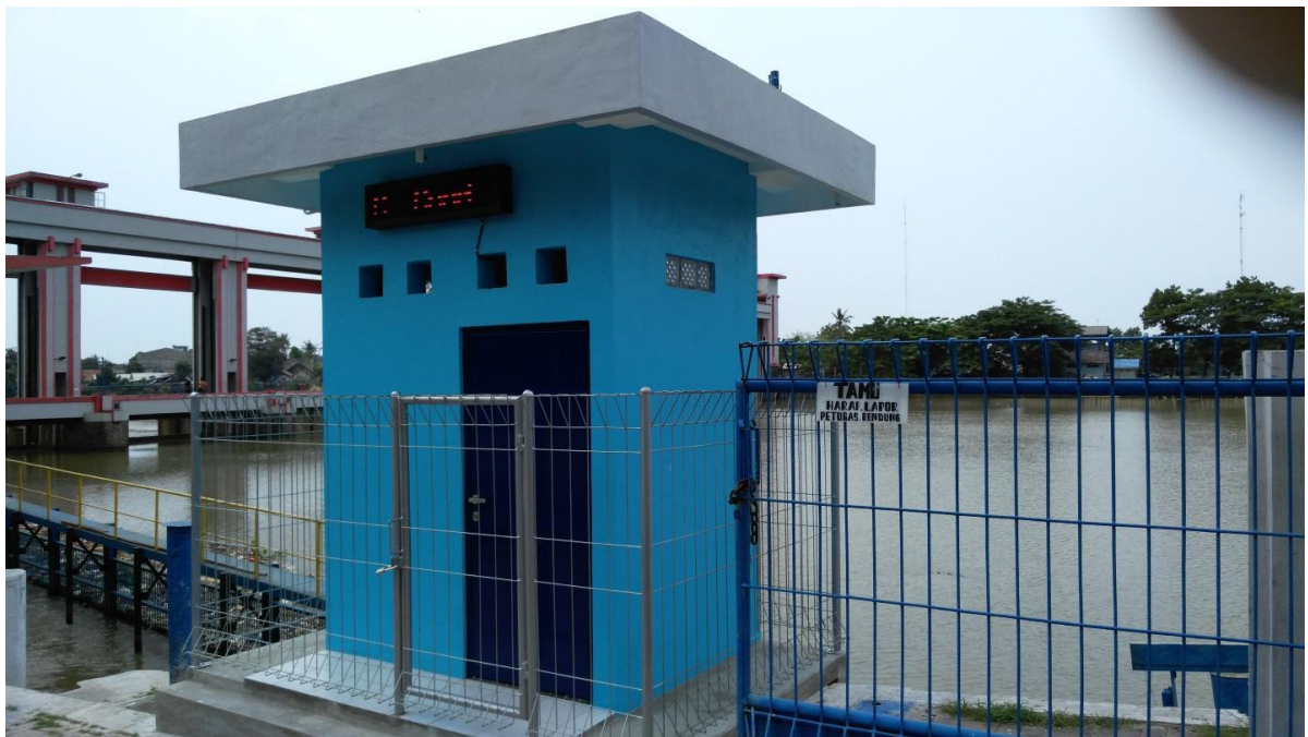
Gambar 5. Contoh Bangunan Pelindung Permanen
